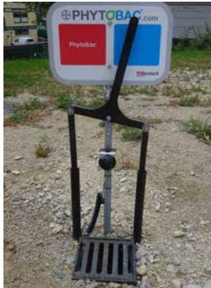
Umschalteinheit für geschlossenen Phytobac-Kreislauf bzw. Abwasserkanal; unterhalb Betätigungsknopf für Stromfreischaltung (Foto: Summerer, LFS)
