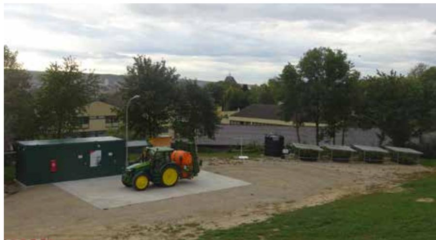
Die neu errichtete Anlage mit Lagercontainer, Waschplatte, Frischwassertank, Puffertank und Pflanzenbeeten (Foto: Summerer, LFS)
