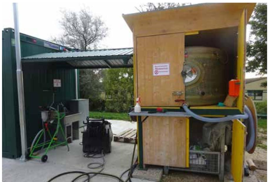
Frischwassertank mit Befüllautomatik und Lagerbox für Leergebinde im unteren Bereich; links im Bild Dampfstrahler, Easy-flow und Waschbecken (Foto: Summerer, LFS)
