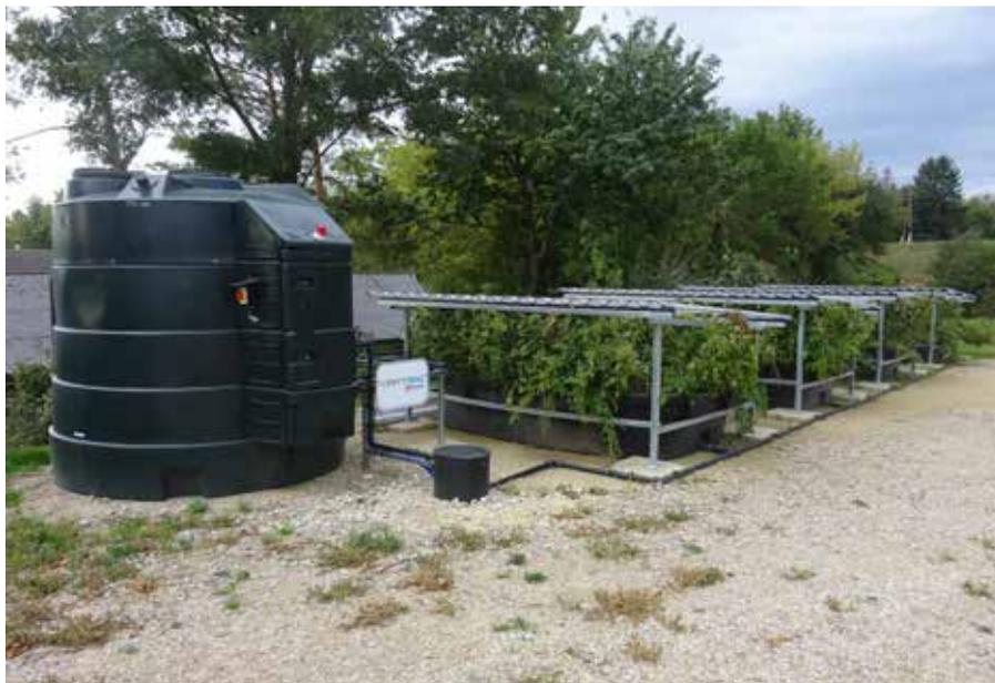
Das Herzstück der Anlage – Puffertank mit Steuerungseinheit und geschlossenen Pflanzenbeeten mit Rücklaufsystem (Foto: Summerer, LFS)
